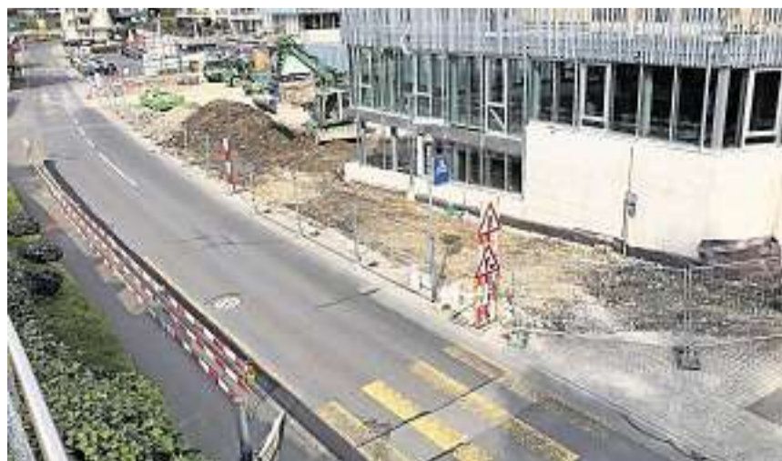
Hier, im Fahrbahnbereich zwischen «Alpenblick» und «Weggishof», entsteht die neue Bushaltestelle. Bild: PD
